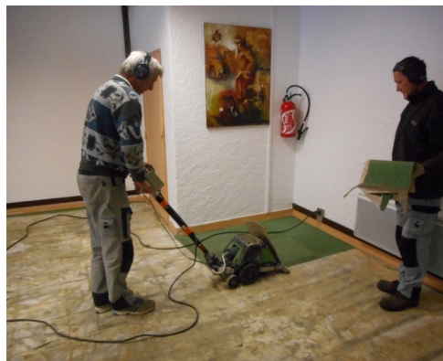
Réfection Salle des Iscles
