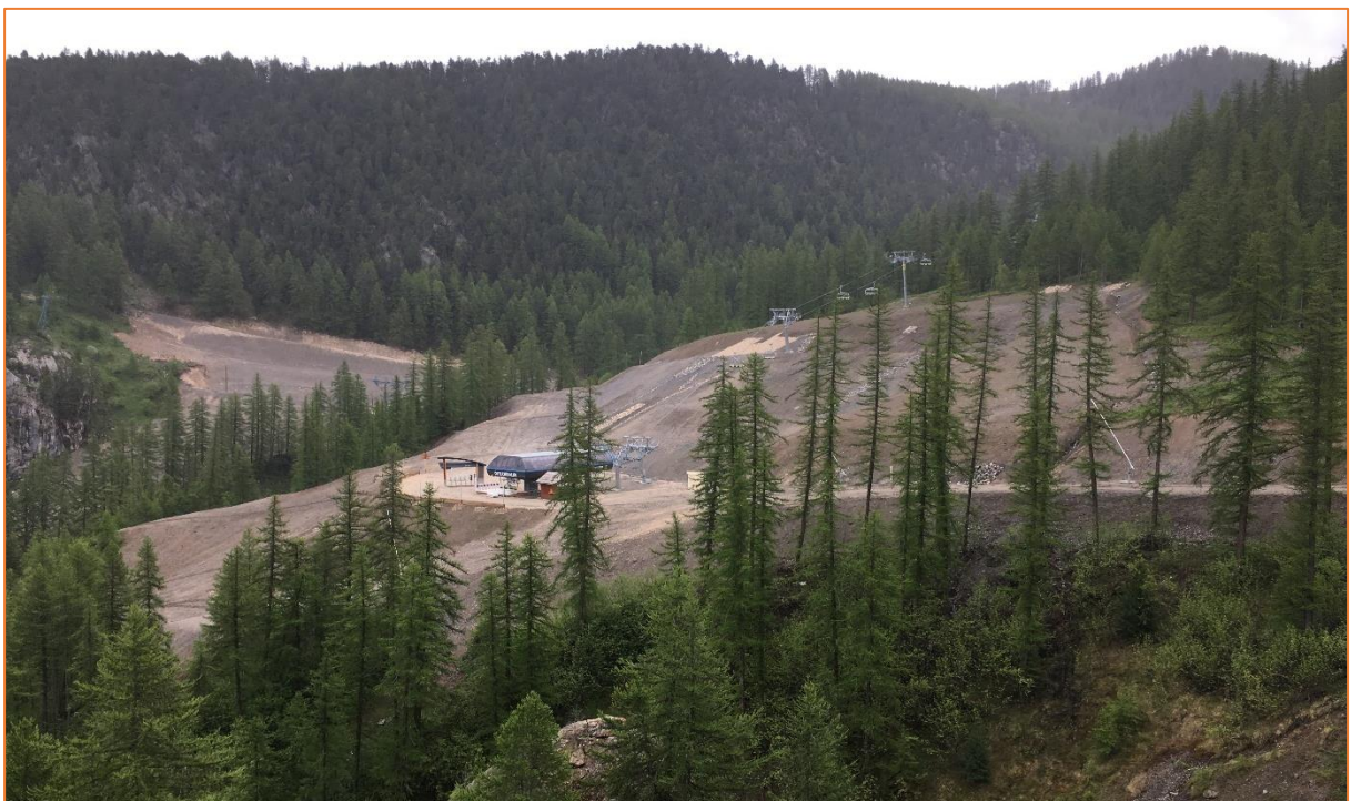
Figure 30 : Photo de la gare aval après travaux (source : AD2i)
