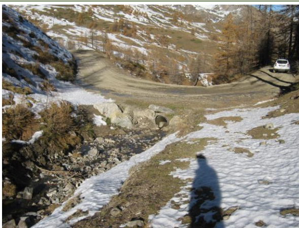
Passage busé sous la piste
