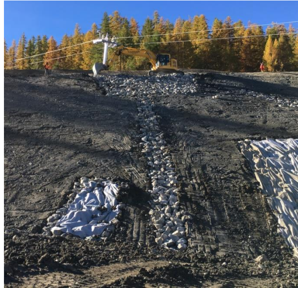
Figure 15 : Exemple d'éperon drainant et de tapis drainant sur le domaine skiable (source : AD2i)
