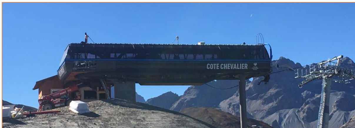
Figure 33 : Photo de la gare amont du TSD6 Côte Chevalier (source : SCV)
