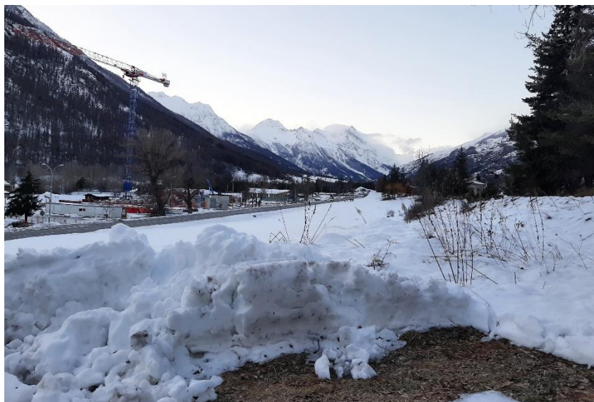
Vue sur le secteur du Pilon depuis le chemin de l'Amanider en direction de l'ouest et travaux en cours sur les Iles Source : Alpicité - 2023
