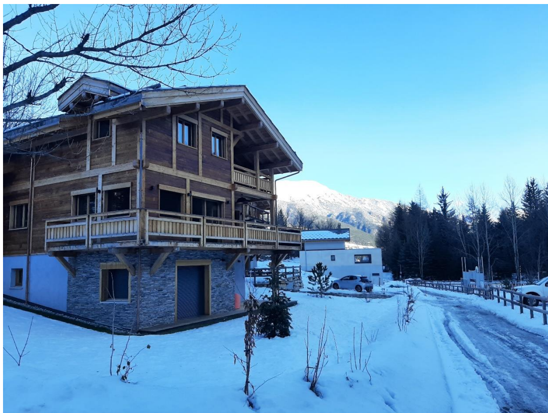
L'accès ouest de la zone de projet, aujourd'hui occupé par 3 habitations individuelles (un lot reste vierge) Source : Alpicité, 2023
