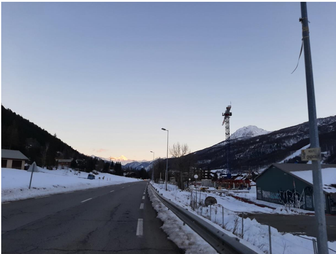
Vue sur le secteur d'OAP depuis la RD1091, travaux en cours sur le secteur 1 (décembre 2023)
