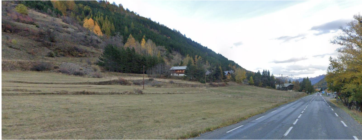
Le secteur du Pilon depuis la route départementale 1091 en direction de l'est Source : Google Street View - 2019
