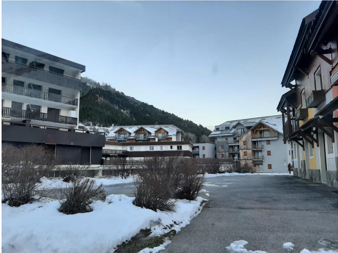
Contexte bâti en limite au niveau de l'allée des Saules Source : Alpicité – 2023
