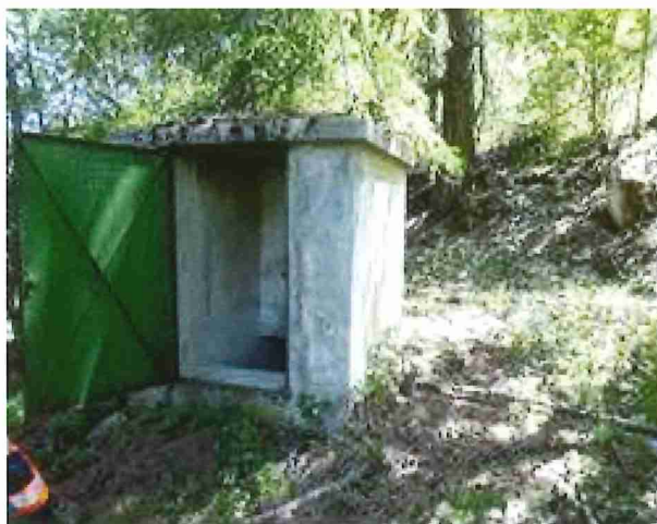
◆Captage de Rochasset
